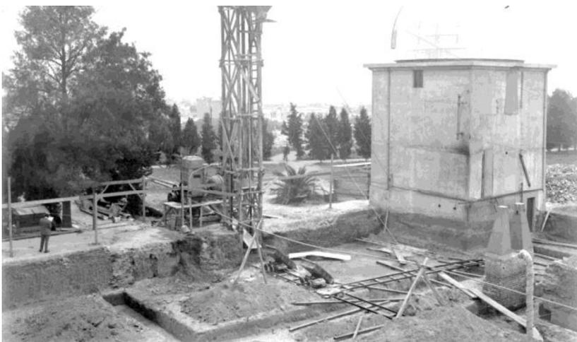
Inicio de la construcción de la nueva sede. Del viejo edificio solo queda el pilar del Círculo Meridiano. La torre visible es la noroeste. La estructura de madera es la base de la grúa (13/1/1924).
