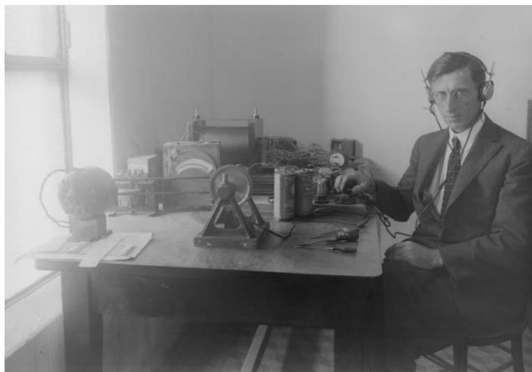
**Meade Zimmer** con el equipo experimental para recibir señales de radio para la medición de la longitud geográfica del observatorio el 24/4/1924.
